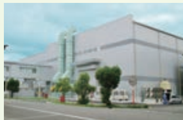
完成した広島製作所新工場
