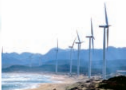
島根県江津市に設置した風力発電機J82 (11基)
