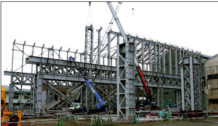
製品加工能力増強のため、機械加工工場建屋を延伸
