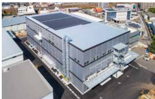
太陽光設置工場
